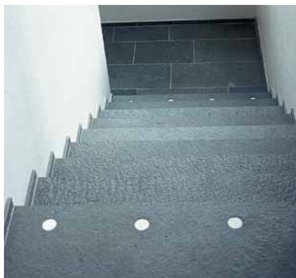
Fig 5.20 Innfelte steinsirkler med hvit farge markerer trappens begynnelse og slutt. Foto: Sveriges Stenindustriförbund.
