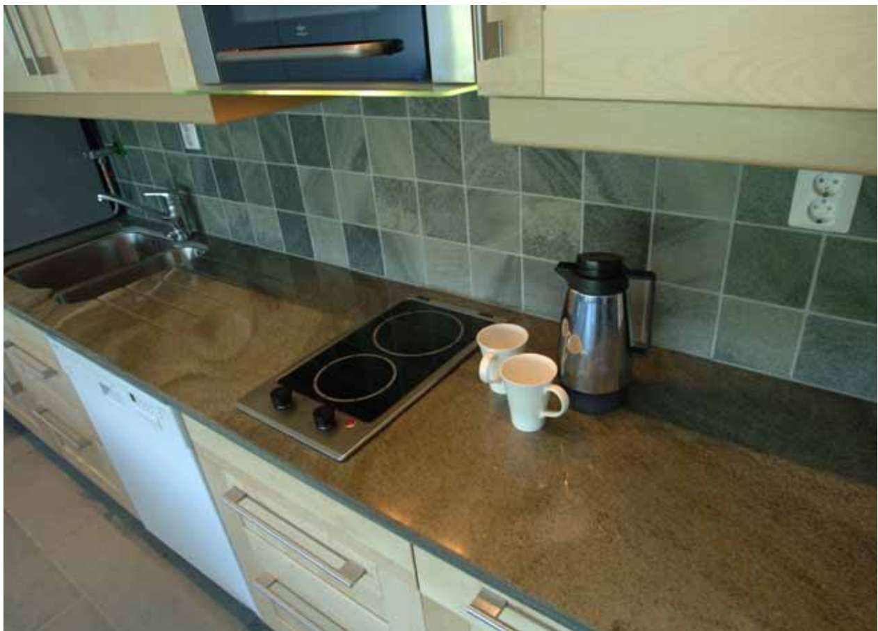
Fig 8.13 Polert benkeplate og slipte veggflis i kvartsittskifer. Merk freste riller i benkeplater ved vask. Foto: Oppdal Sten AS.
