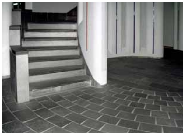
Fig 5.15 Forblandet trapp med hele trinn og gulv med Altaskifer. Foto: Minera Norge AS.
