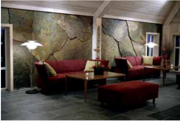
Fig 6.2 Store bruddheller av rustskifer på vegg og kvartsittskifer med naturplan og i fallende lengder på gulv. Rondeslottet Høyfjellshotell, Otta. Foto: Minera Norge AS.
