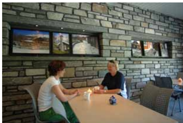
Fig 6.10 Skifer som i utgangspunktet er tenkt for tørrmuring, kan også alternativt mures opp med fuger. Foto: Oppdal Sten AS.
