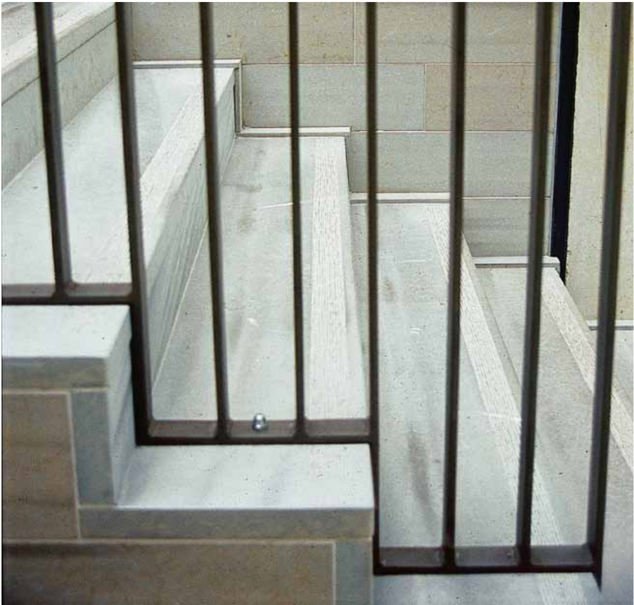
Fig 5.31 Freste spor i trinnenes framkanter gir sklisikkerhet og visuell markering. Foto: Sveriges Stenindustriförbund.
