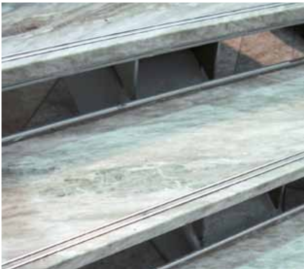
Fig 5.22 Metallister innfelt i steinen kan gi sklisikkerhet og god, visuell effekt. Foto: Sveriges Stenindustriförbund
