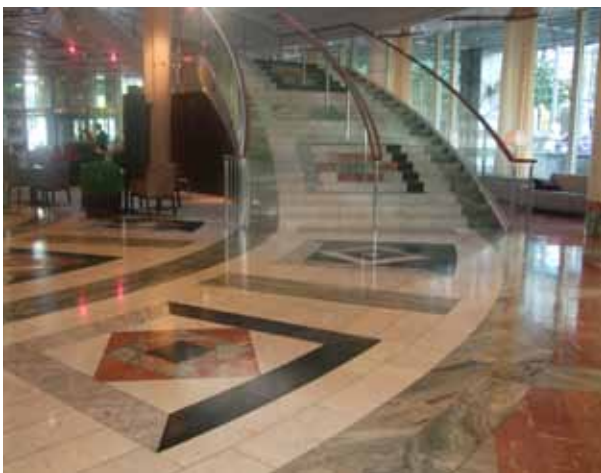
Fig 4.47 Gulv med flere typer naturstein der selve hovedmønsteret leder mot trapp. Radisson SAS Plaza Hotel, Oslo. Foto: SINTEF Byggforsk.
