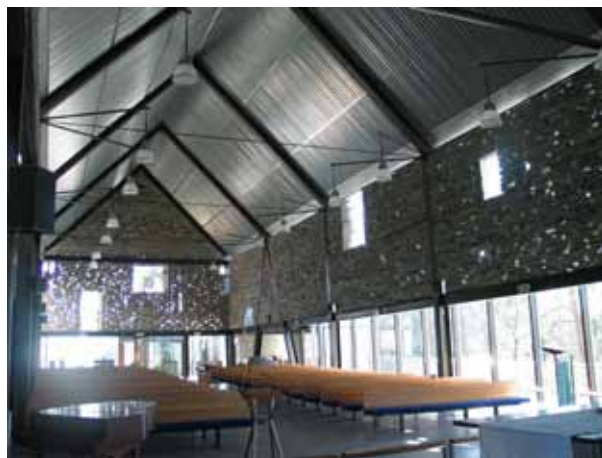
Fig 6.19 Røff stablet og grov tørrmur av skifer mot glassflater gir en spesiell effekt. Mortensrud kirke. Foto: Minera Norge AS.
