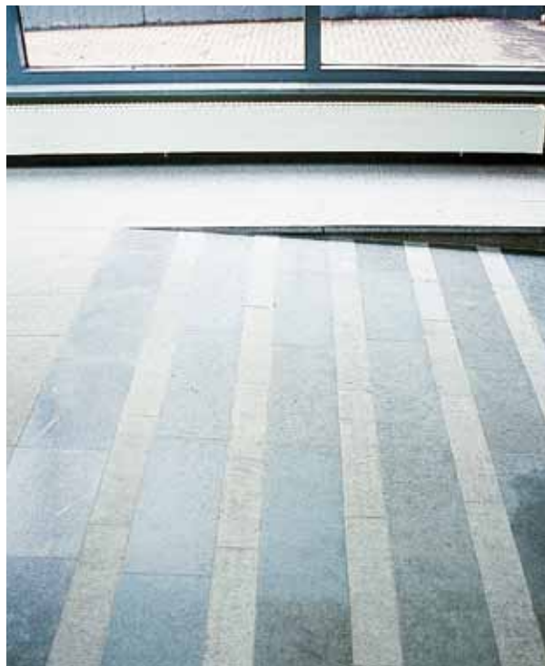
Fig. 4.43. Entré til kontorbygg med skrått inngangparti i kalkstein. Grovhogde bånd bidrar til sklisikkerhet og gir en visuell, taktil markering. Foto: Sveriges Stenindustriförbund.
