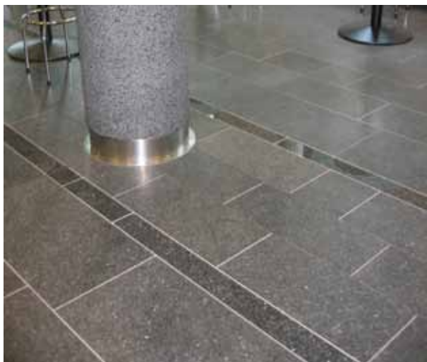
Fig 4.5 Ulik overflatebearbeiding gir gode kontraster i gulv. Finslipt og polert larvikitt (Bergan) i fallende lengder. Hedmark Sparebank. Foto: Nordicstone AS.
