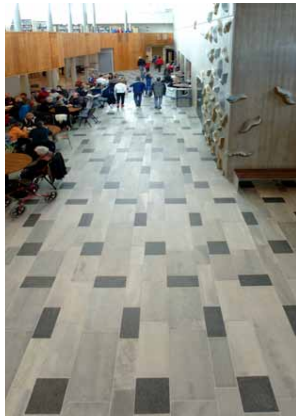
Fig.4.4 Bruk av ulike skifervarianter gir mønstereffekt i gulvet. Oppdal- og Ottaskifer med børstet overflate. Oppdal kulturhus. Foto: Minera Norge AS.
