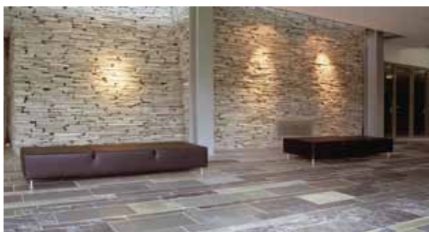
Fig. 6.9 Skifer tørrmur med åpne fuger. Foto: Minera Norge AS
