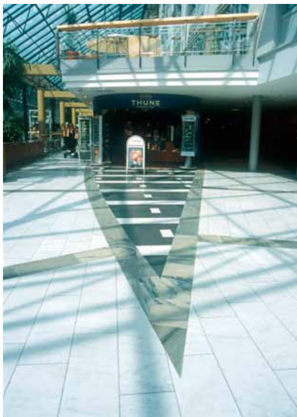
Fig 4.3 Gulv med finslippt marmor og skifer. Solsiden Kjøpesenter, Trondheim. Foto: SINTEF Byggforsk.
