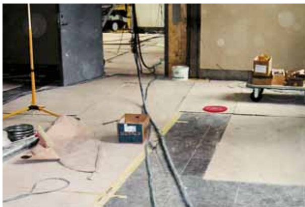
Fig 4.53 Avskrekkende eksempel der tildekkingen er utført slik at den ikke beskytter gulvet mot aktuelle belastninger. Foto: Sveriges Stenindustriförbund.
