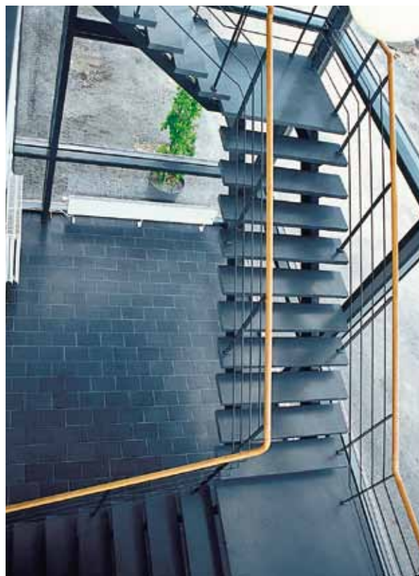
Fig 5.18 Trapp med selv bærende trinn på stålkonstruksjon. Foto: Sveriges Stenindustriförbund.
