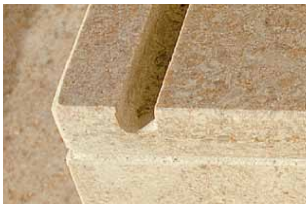
Fig 5.27 Frest spor ved inntrinnets framkant. Foto: Sveriges Stenindustriförbund.
